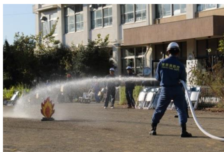
スタンドパイプからの放水
